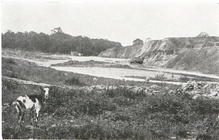
Vue des travaux de déblai exécutés au lieu dit Beukenberg (percement de l'avenue d'Huart). L'espèce de falaise au pied de laquelle stationne un camion automobile montre l'épaisseur des couches de sables tertiaires formant le sous-sol du territoire forestois.
